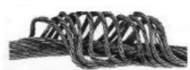
FIG. 14.4 — Alma do cabo a descoberto, com aumento local do diâmetro devido à abertura. Este estado exige a substituição.
