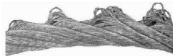
FIG. 7.3 — Grave defeito localizado com saída dos cabos interiores dos cordões, devido a repetidos solavancos. Este estado exige a substituição imediata.
