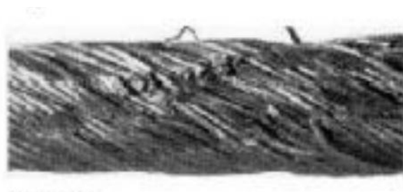
FIG. 14.2 — Grave desgaste e número notável de fios rotos. Atrito sob tensão sobre aresta viva. Este estado exige a substituição imediata.
