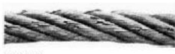
FIG. 14.1 — Rotura de fios em vários cordões adjacentes de um mesmo cabo com enrolamento cruzado (garganta da roldana demasiado estreita). Este estado exige a substituição.
