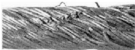
FIG. 9.2 — Grave desgaste e número notável de fios rotos. Atrito sob tensão sobre aresta viva. Este estado exige a substituição imediata.
