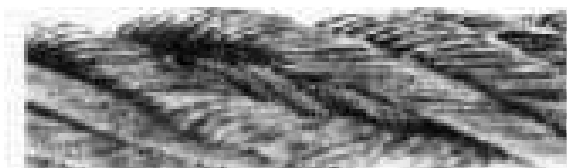
FIG. 10.4 — Alma do cabo a descoberto, com incremento local do diâmetro devido à abertura. Este estado exige a substituição.
