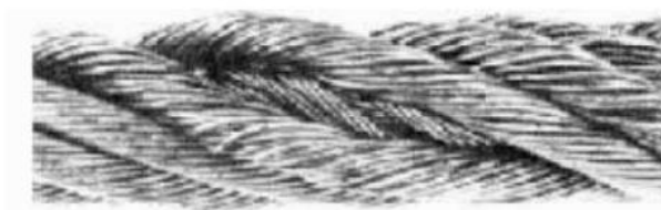
FIG. 7.4 — Âme du câble à découvert, avec augmentation locale du diamètre due à l'ouverture. Cet état exige le remplacement.
