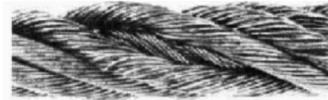
FIG. 9.4 — Núcleo del cable al descubierto, con incremento local del diámetro debido a la abertura. Dicho estado requiere la sustitución.
