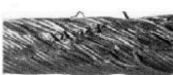
FIG. 14.2 — Grave desgaste y número notable de hilos rotos. Rozamiento bajo tensión sobre arista viva. Dicho estado requiere la sustitución inmediata.
