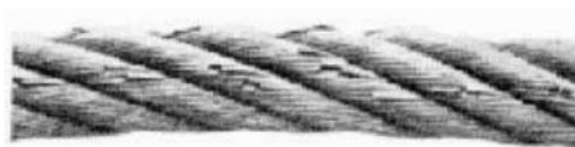
FIG. 9.1 — Rotura de hilos en varios haces adyacentes de un mismo cable con enrollamiento cruzado (garganta de la polea demasiado estrecha). Dicho estado requiere la sustitución.
